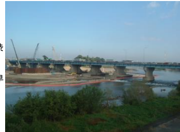
国道 1 号（矢作橋）
